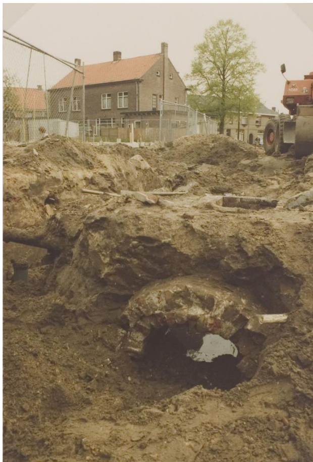
Restanten van de overkluide Zuider- of Platte Beek liggen nog steeds onder het wegdek.
